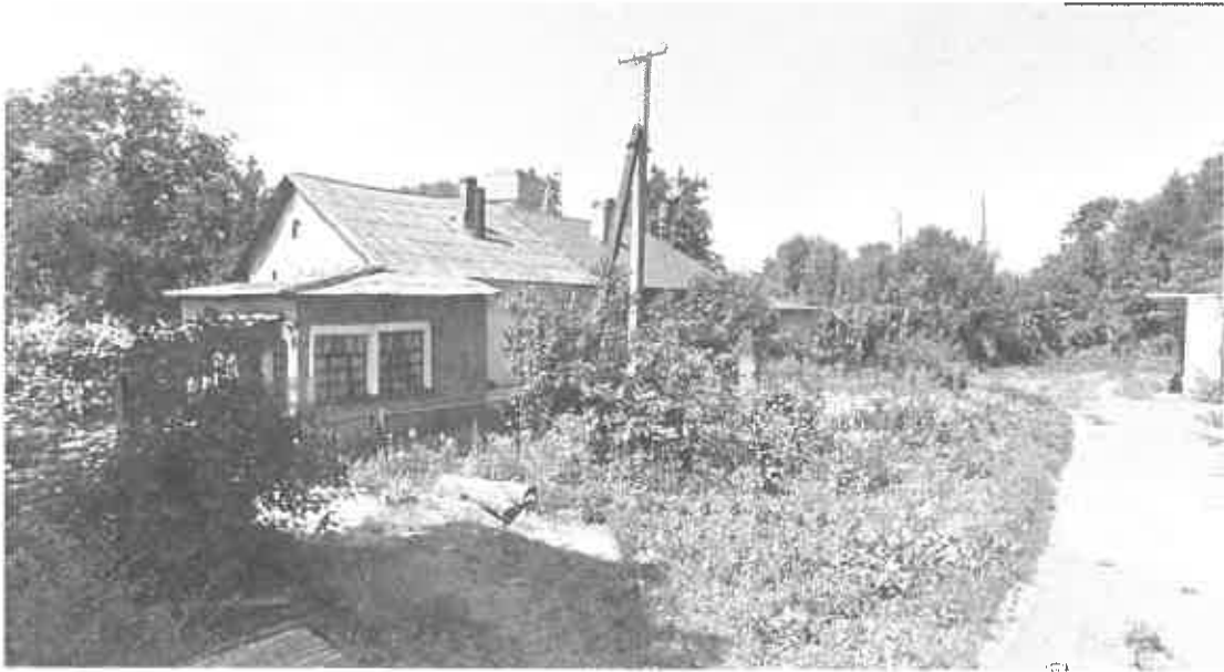
Рисунок 2 Будинок № 18 по вул. Філатова
