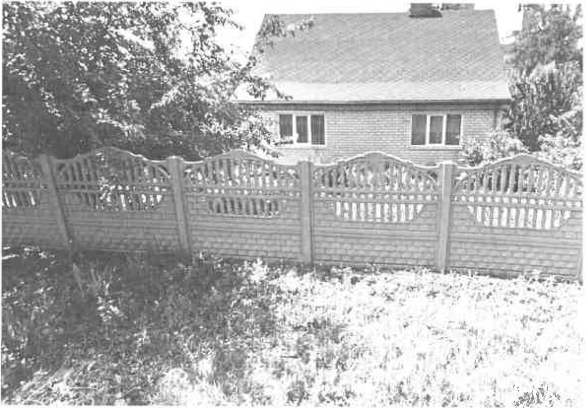
Рисунок 2 Будинок №2 по вул. Філатова
