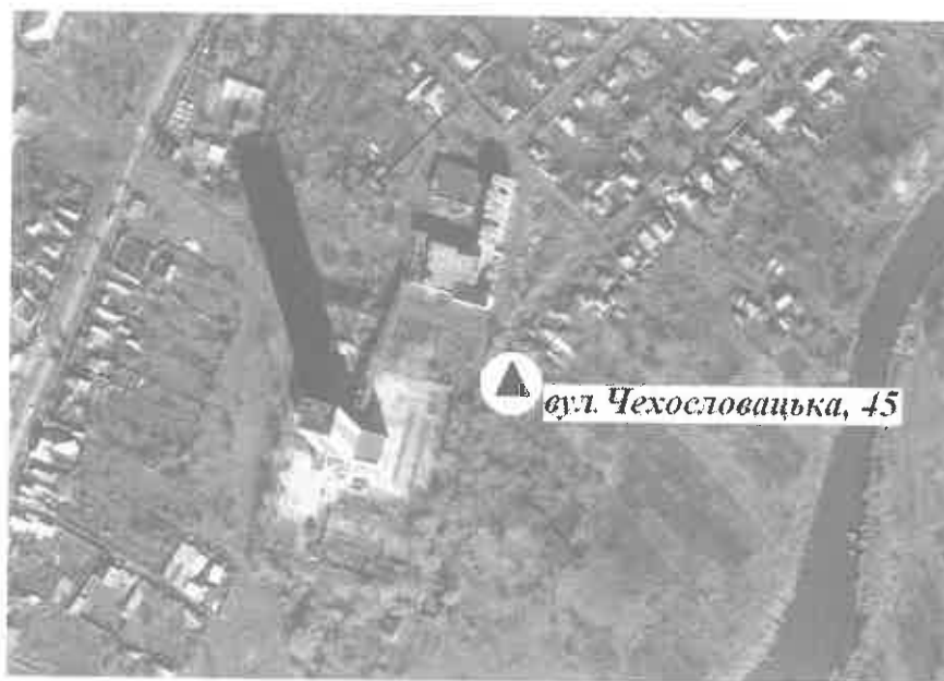
Рисунок 1 Район розташування об'єкта, під час проведення робіт 28 квітня 2021 р.
