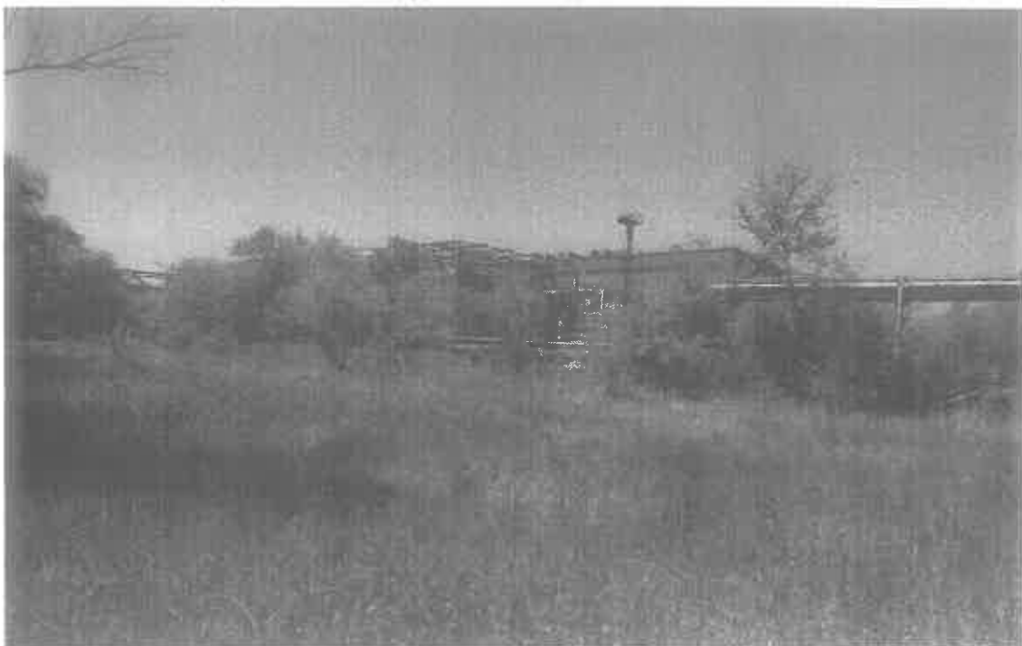
Рис.6 Загальний вид на шлакове відділення зі східної точки
