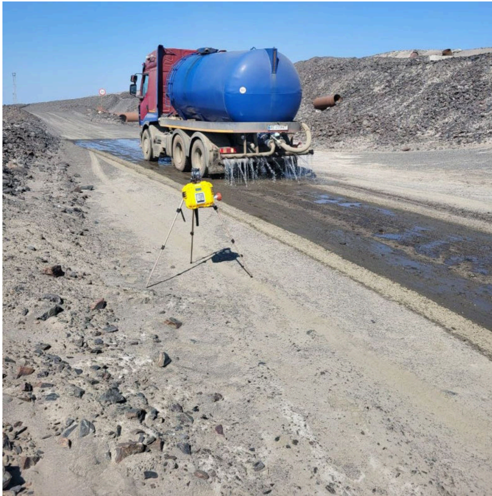
Зображення № 2 — рух поливозрошувальної техніки під час поливу водою автодороги хвостосховища «IV карта»
