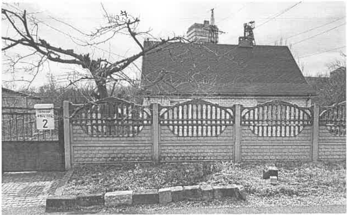
Рисунок 2 Будинок № 2 по вул. Філатова
