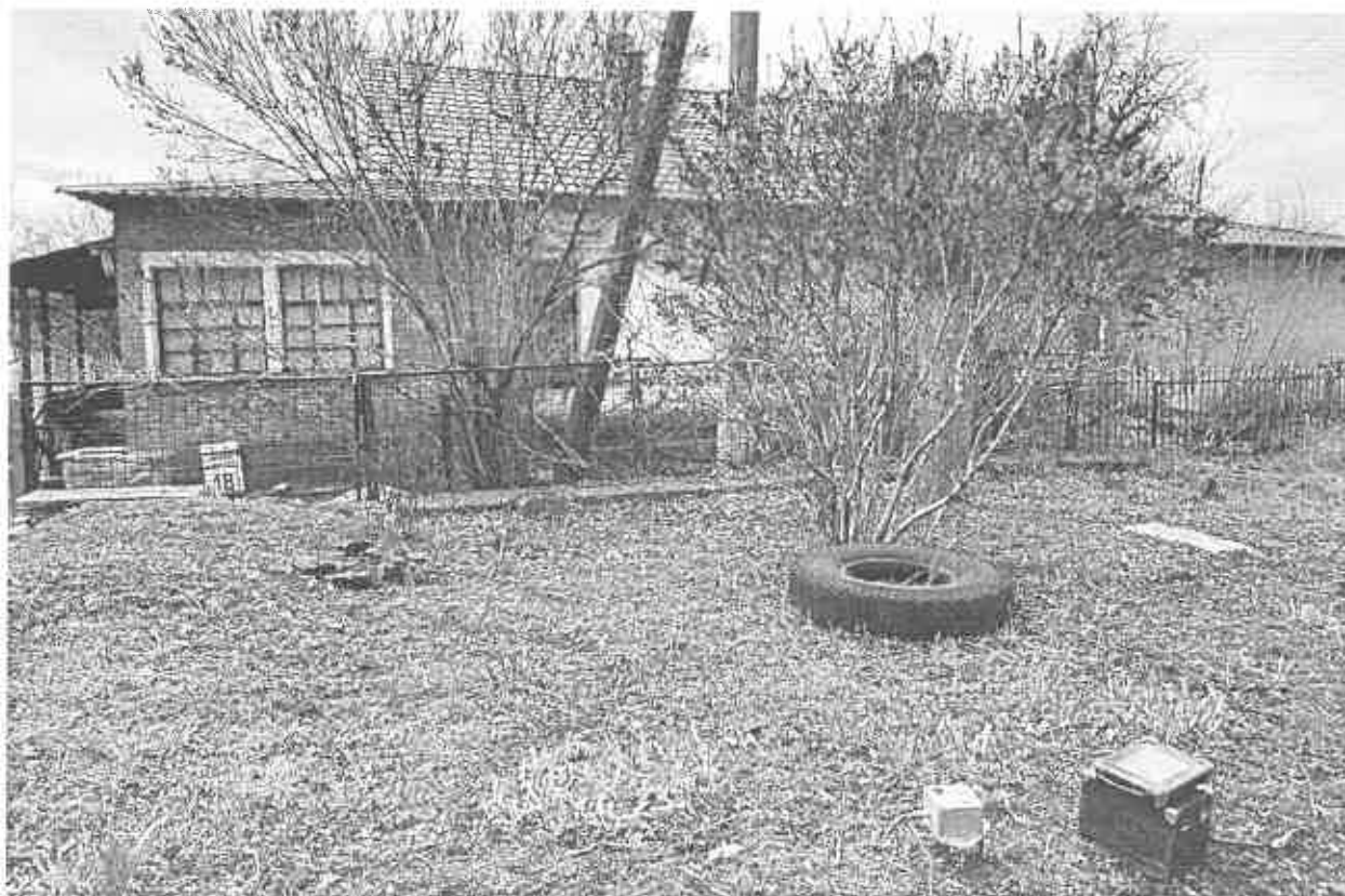
Рисунок 2 Будинок № 18 по вул. Філатова
